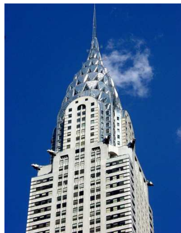
Edifici Chrysler, Nova York
